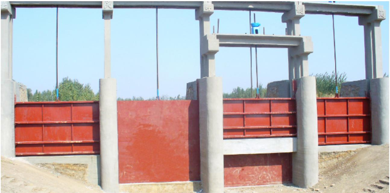
闸门的安装（1）平面闸门及其门槽埋设件的安装，应按施工图纸的规定进行。（2）平面闸门的埋设件安装，应符合DL/T5018-94第、第。（3）闸门主支承部件的安装调整工作应在门叶结构拼接装焊完毕，经过测量校正合格后方能进行。所有主支承面应当调整到同一平面上，其误差不得大于施工图纸的规定。（4）充水装置和自动挂脱梁定位装置的安装，除应按施工图纸要求外，还需注意与自动挂脱梁的配合，以确保安全可靠地动作。（5）平面闸门水封装置的安装技术要求，应按规定执行。（6）平面闸门安装完毕后，应埋件表面的门叶上的所有杂物，特别注意不锈钢水封座板表面的水泥浆。在滑道支承面和滚轮轴套涂抹或灌注润滑脂。（7）经监理人检查合格的平面闸门及门槽埋件，方能按规定进行涂装修补。（8）平面闸门安装完毕，应作静平衡试验。试验方法为：将闸门自由地吊离地面100mm通过滚轮或滑轮或滑道的中心测量上、下游方向与左、右方向的倾斜，单吊点平面闸门的倾斜不应超过门高的1/1000，且不大于8mm平面链轮闸门的倾斜应不超过门高的1/1500，且不大于3mm当超过上述规定时，应予配重调整。
